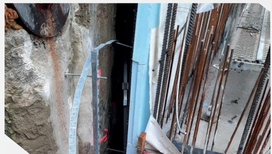
*Bohrpfähle mit Injektion, justierte Befestigung
