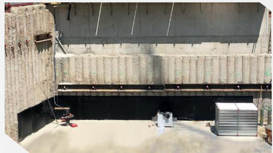
*Bohrpfähle mit Injektion, direkte Befestigung.
