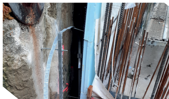
Bohrpfähle mit Injektion, justierte Befestigung mit Kaschierung.
